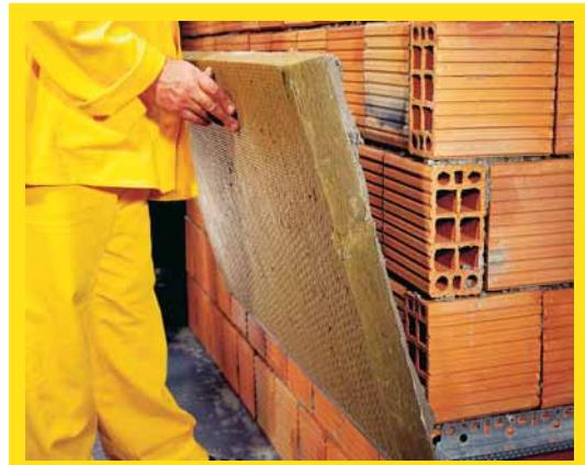
*Yapıştırma harcı tamamen kuruduktan sonra (yaklaşık 24 saat) dübelleme işlemine başlanır. Duvar özelliklerine uygun olarak seçilen özel yalıtmış tespit dübelleri, m<sup>2</sup>'ye 6 adet gelecek şekilde uygulanır. Fayans veya eskimiş sivalardan oluşan yüzeyler, dübelleme işlemi için uygun değildir.*
