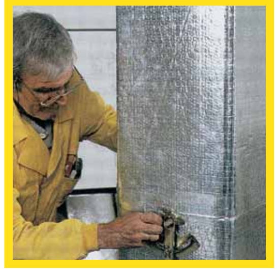
Prefabrik Klima Kanallarının hava damper montajının yapılması
