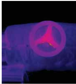
İzocam Vana Ceketı uygulamasından sonra yalıtımlı vananın termal kamera görüntüsü
