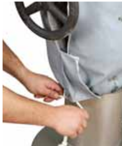
Paslanmaz yay yardımıyla, kopçalar birbirine sıkıca bağlanır.
