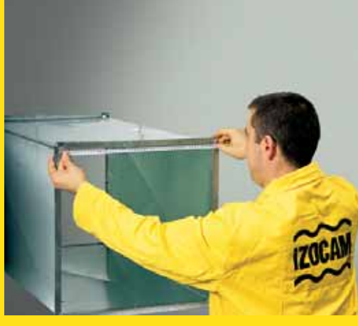
Yalıtım yapılacak kanalın içten içe ölçüsü alınır.
