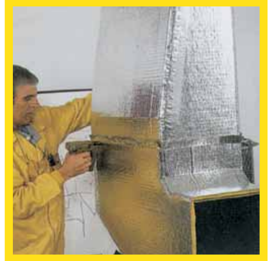
Prefabrik Klima Kanalları birleştirme yerlerinin zımbalanması
