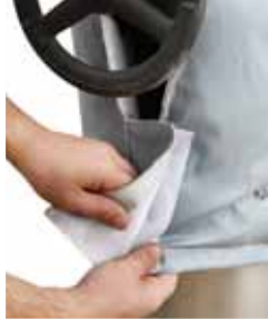
Yalıtımı yapılacak vanaya uygun vana ceketini seçilir veya özel olarak hazırlanır.
