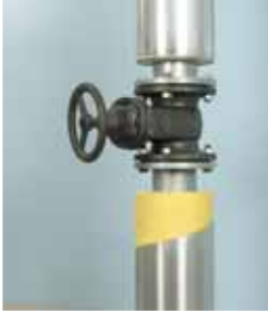
Yalıtımı yapılacak vanaya uygun vana ceketini seçilir veya özel olarak hazırlanır.
