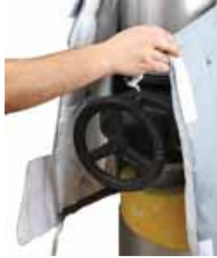
Yalıtımı yapılacak vanaya uygun vana ceketini seçilir veya özel olarak hazırlanır.
