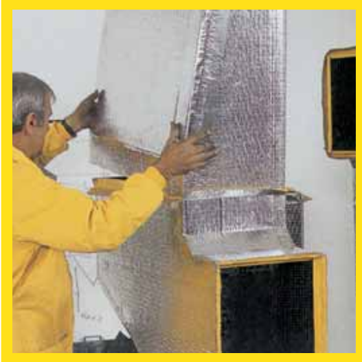
Prefabrik Klima Kanallarının birbirine eklenmesi
